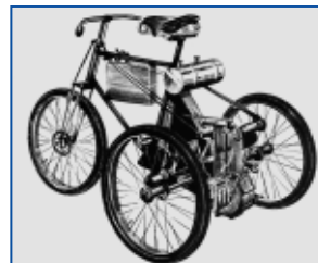
1897: трицикл с низковольтным магнето Bosch
